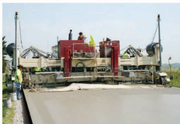
SF-3000 оснащенный системой бескапирного управления 3D.
