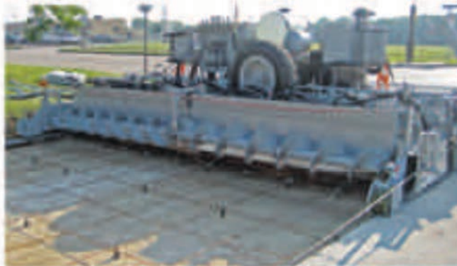
▲ рельсовые бетоноукладчики Power Pavers FP-2700 и FP-3000
