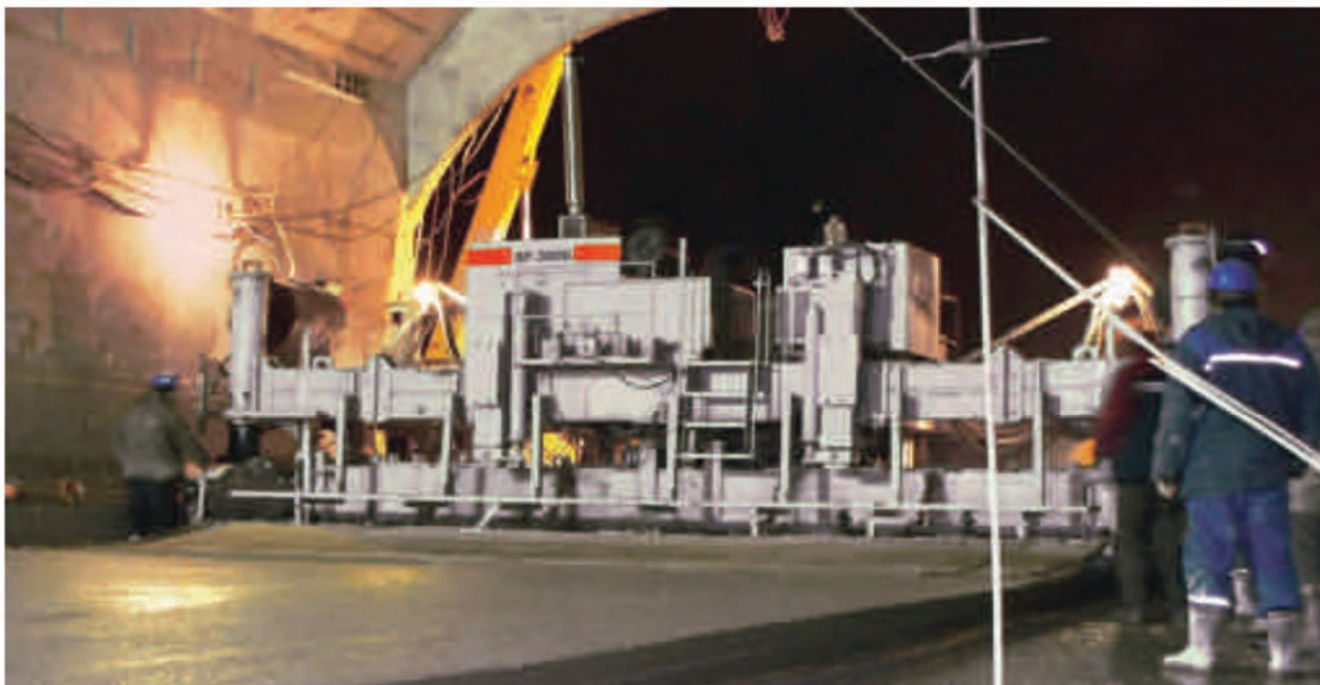
SF-3000 укладывает дорожное покрытие в Краснополянском тоннеле (г.Сочи)
