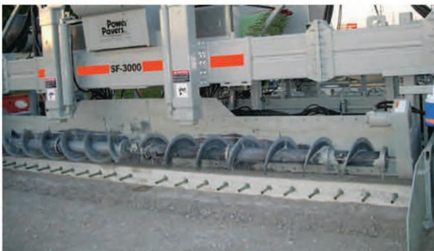
Раздвигаемые боковые формовочные стенки позволяют продолжить укладку с минимальной необходимой обработкой места стыка в ручную, что обеспечивает максимальную равномерность укладываемого покрытия
