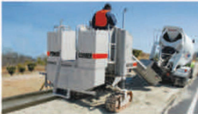
▲ бетоноукладчик монолитных профилей Power Curbers 5700-C
